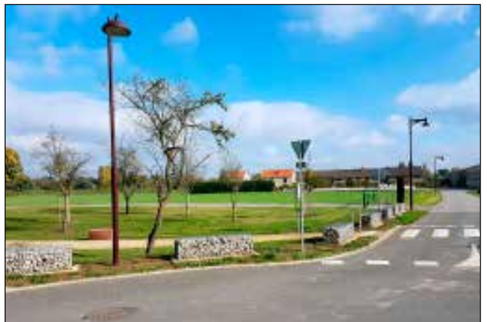
Pose de gabions au rond-point chemin de la Moselle et près de la salle des fêtes.
