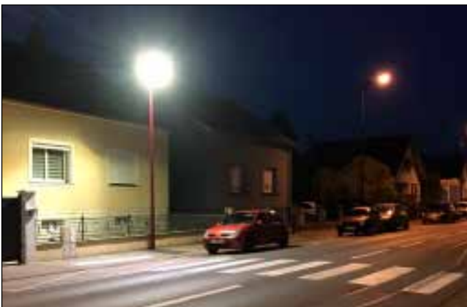
Ajout de points lumineux pour la protection des passages piétons route de Maizières et aux bretelles d'autoroute.
