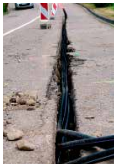
Tranchée permettant l'enfouissement de la Fibre Optique alimentant le village, la pôle industriel du Malambas et le carrefour d'activités Hauconcourt - Talange.
