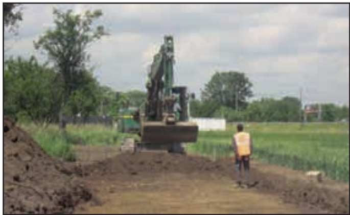
Début des travaux.
