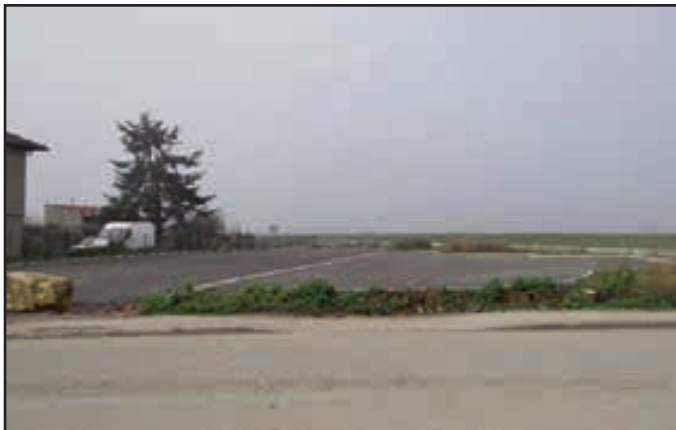
Création du nouveau parking.
