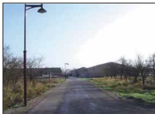
Aménagement « Chemin de la Moselle »
