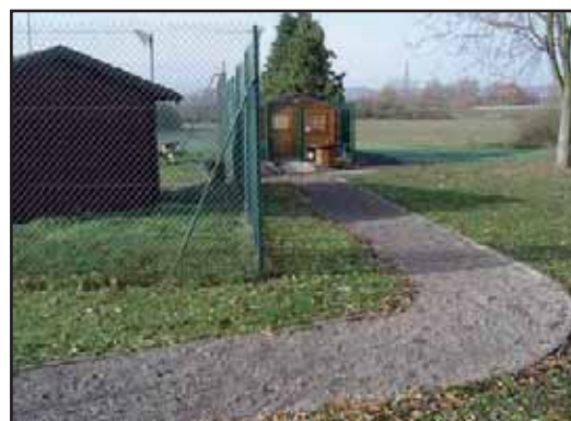
Rénovation du chemin piétons au tennis
