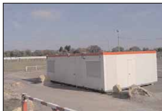
Pose de modules au terrain de foot
