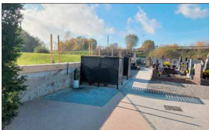
Création d'un box pour les poubelles et mise en place de deux fontaines à eau.
