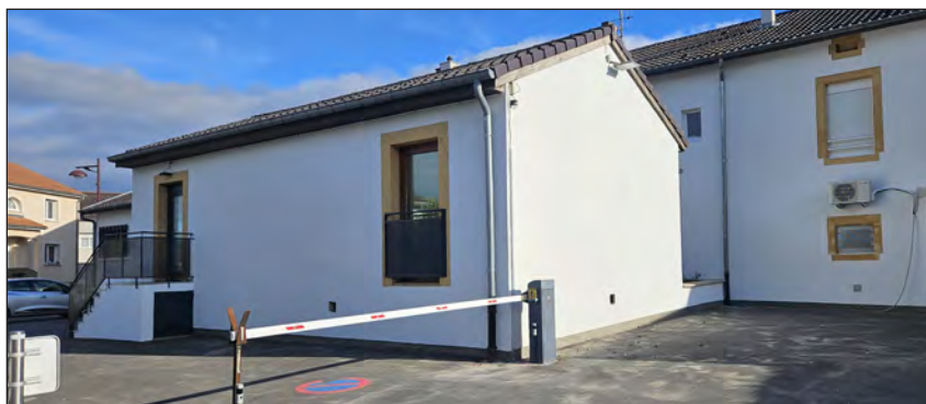
Ravalement de la façade arrière de la mairie.
