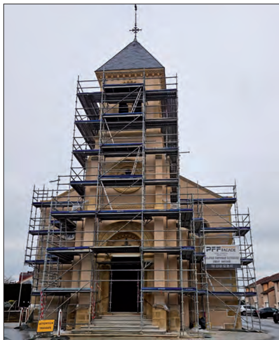
Réfection en cours du clocher et de la façade avant de l'église.
