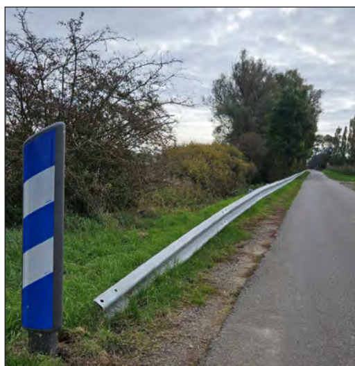
Pose d'une glissière de sécurité sur une partie du chemin de Talange.
